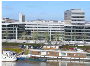
Le River Plaza à Asnières © cushwakeproperty.com
